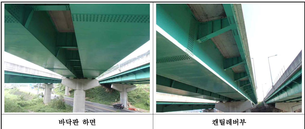
【사진 3.2.1】 바닥판 전경(대구)
