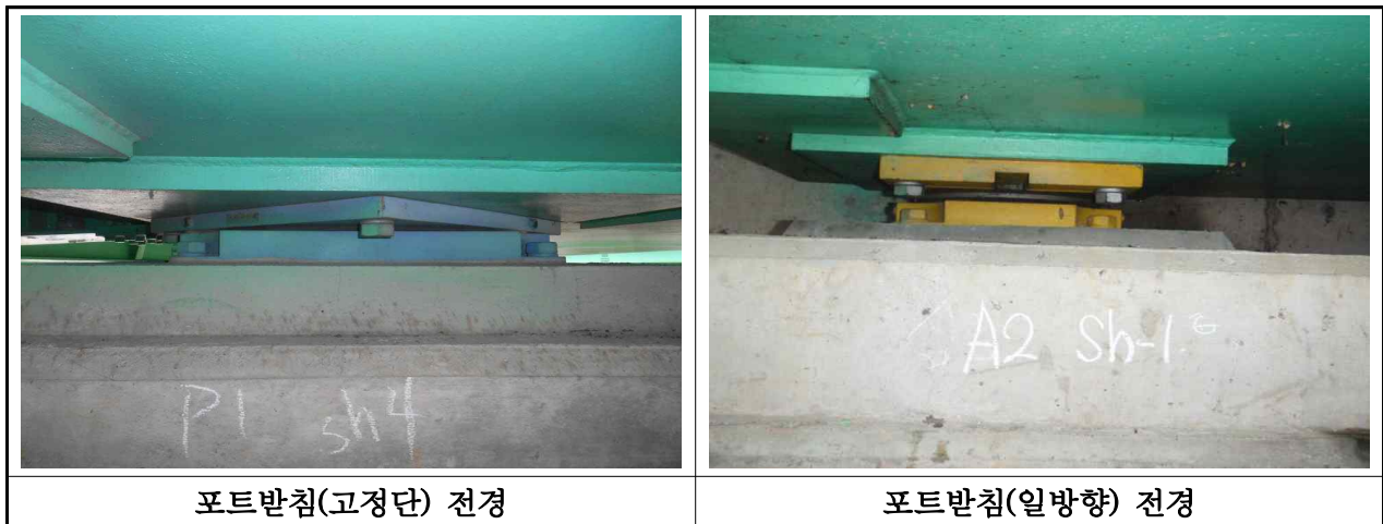
【사진 3.3.11】 교량받침 전경(부산)
