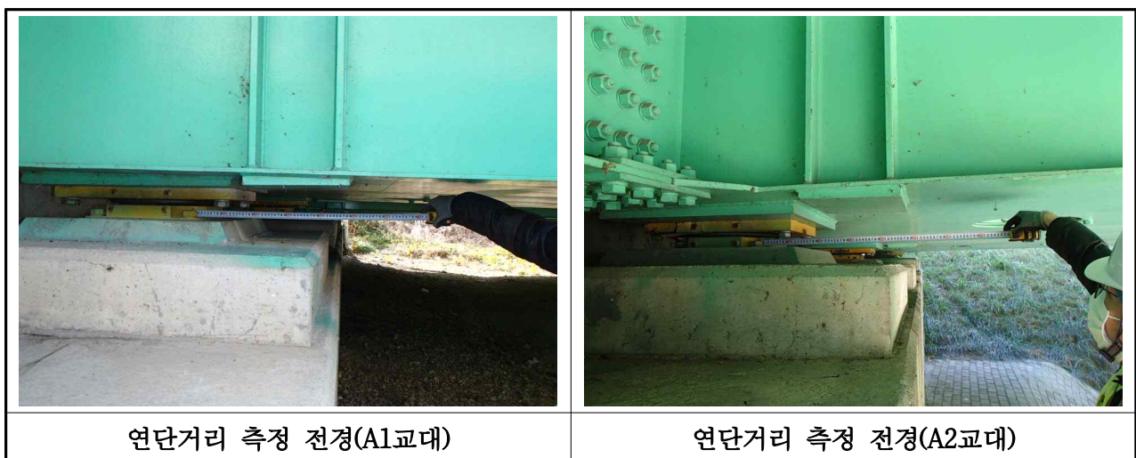
【사진 3.3.13】 연단거리 측정 전경
