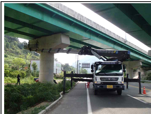
고소점검차를 이용한 조사(1)
