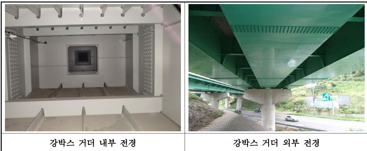
【사진 3.3.3】 강박스 거더 전경(부산)
