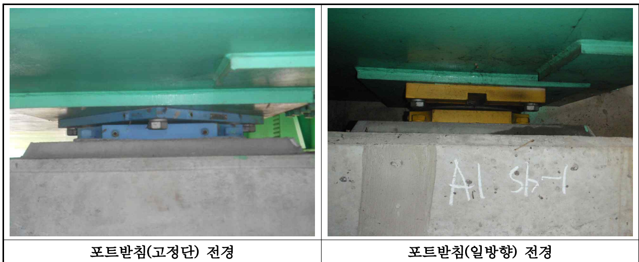
【사진 3.2.11】 교량받침 전경(대구)
