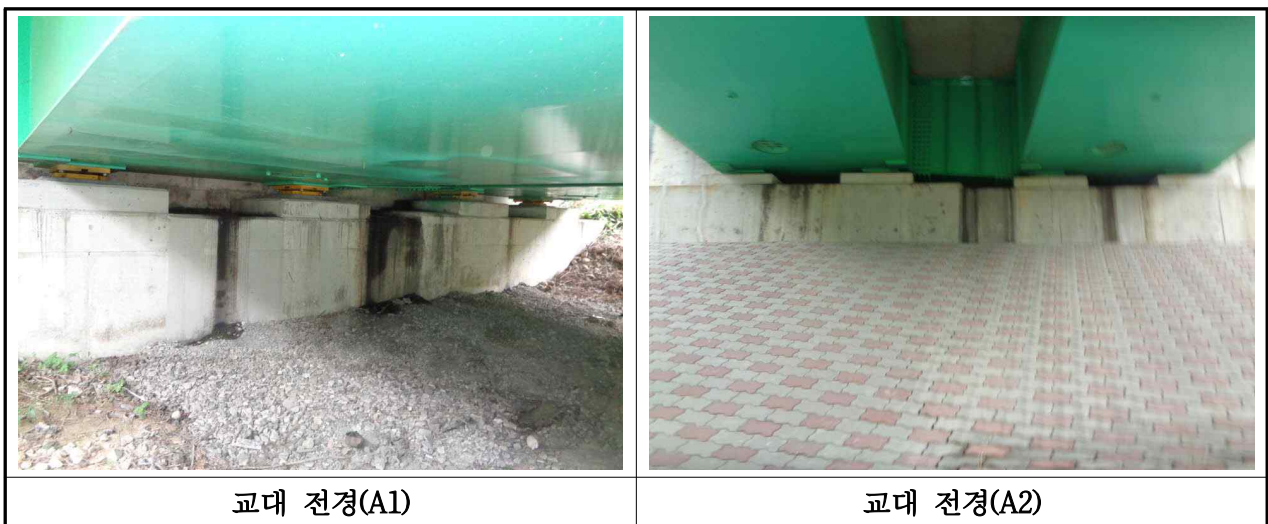
【사진 3.2.7】 교대 전경(대구)
