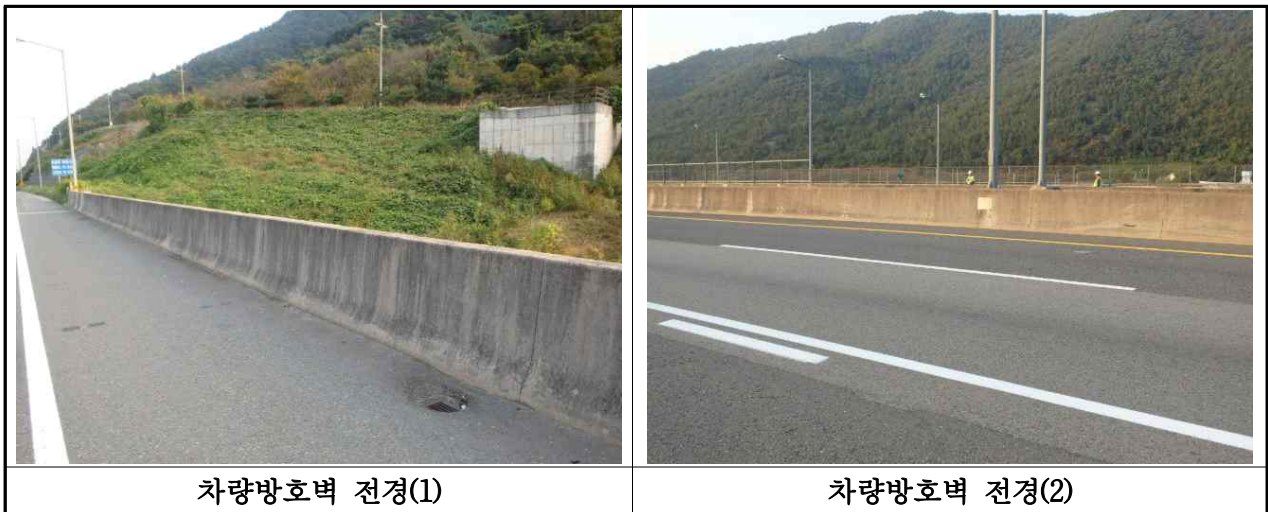
【사진 3.3.20】 방호벽 전경(부산)
