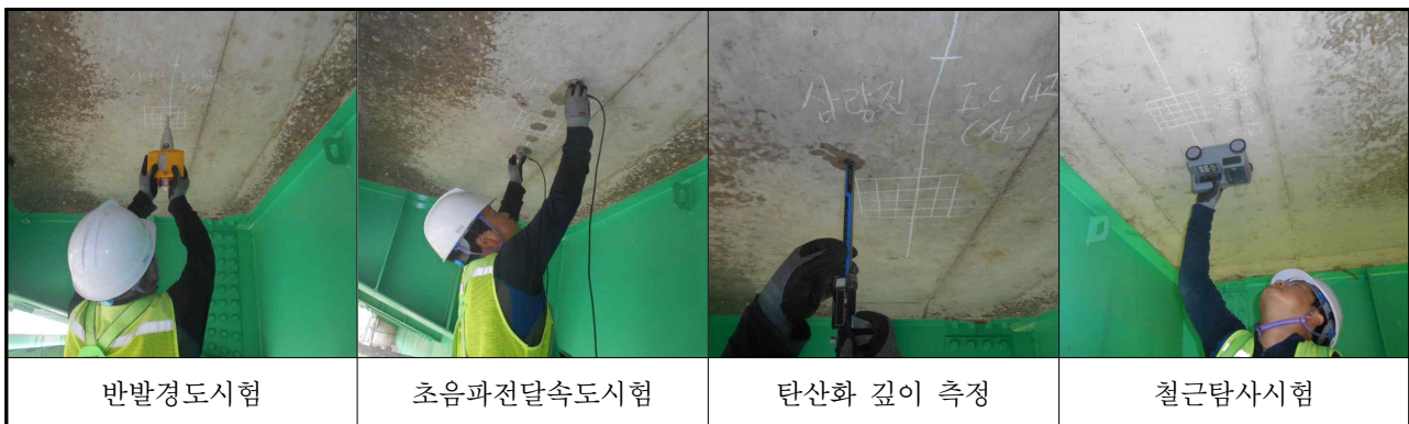
【사진 3.4.1】콘크리트 내구성조사 전경
