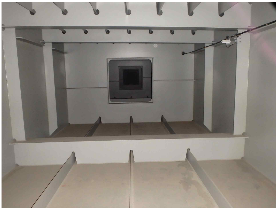
Steel Box Girder 내부 전경
