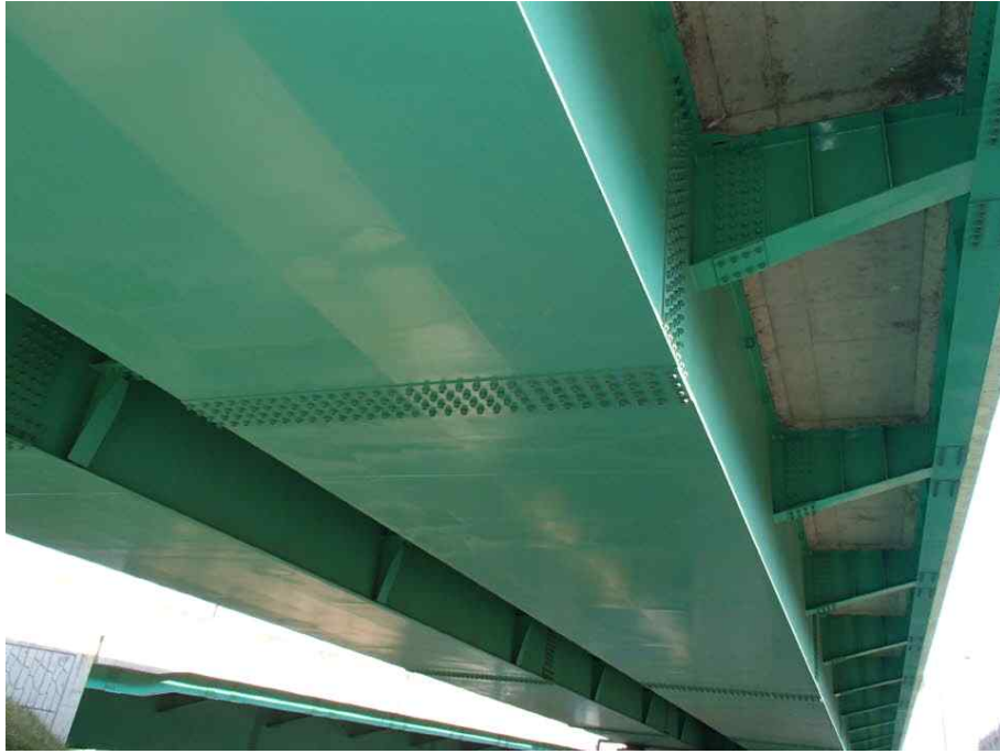
Steel Box Girder 외부 전경
