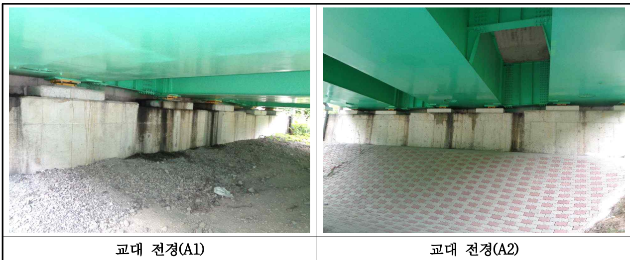
【사진 3.3.7】 교대 전경(부산)
