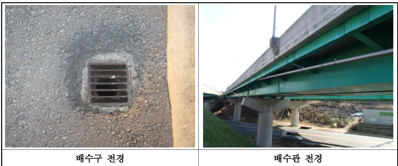
【사진 3.2.18】 배수구 및 배수관 전경(대구)
