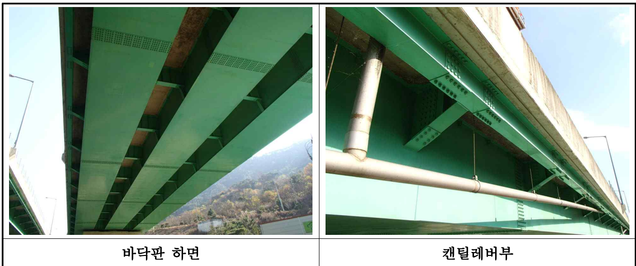
【사진 3.3.1】 바닥판 전경(부산)
