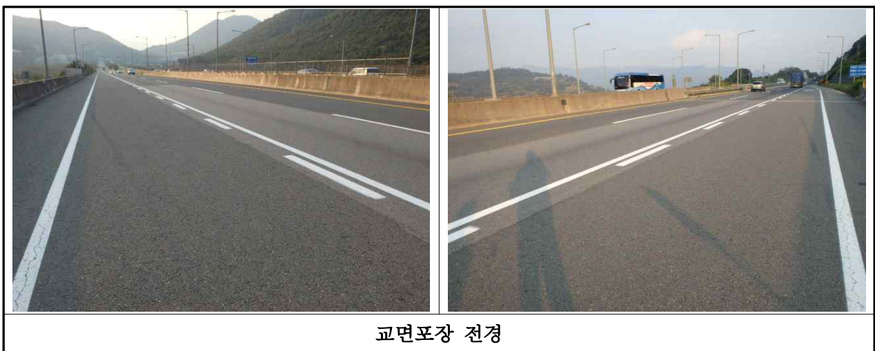
【사진 3.3.16】 교면포장 전경(부산)
