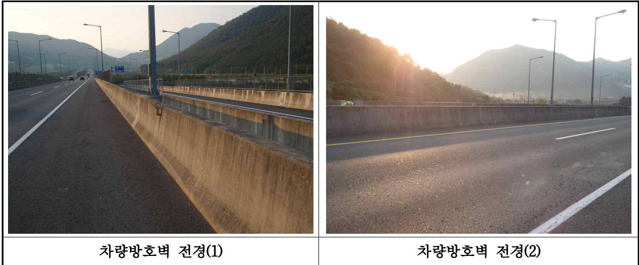
【사진 3.2.20】 방호벽 전경(대구)
