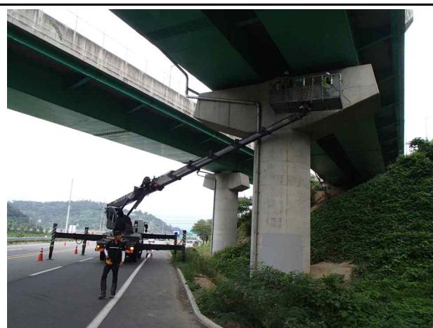
고소점검차를 이용한 조사(2)
